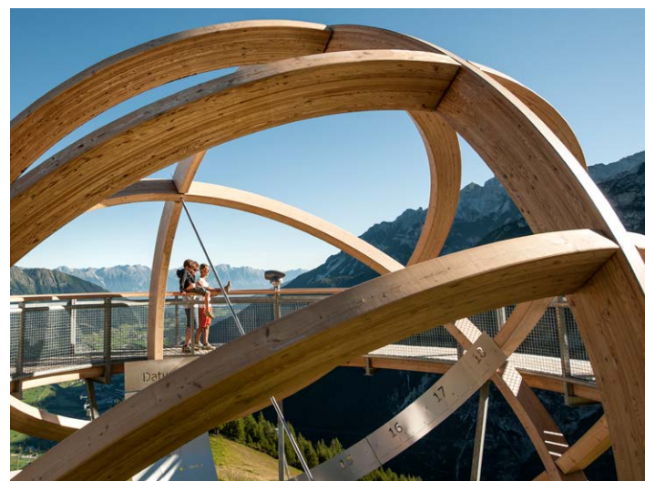
Begehbare Sonnenuhr an der Bergstation der Elferbahnen
